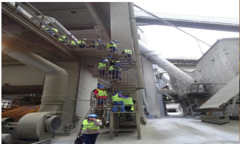
Maj 2014r. - Cementownia w oraz instalacja do unieszkodliwiania odpadów niebezpiecznych - Norcem AS Brevik
